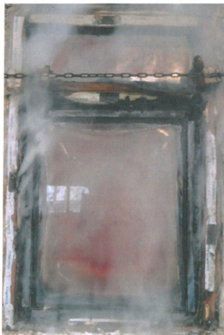
照片二 耐火试验结束时试件情况
